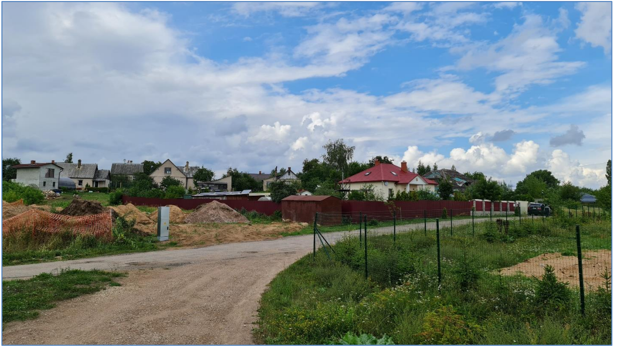
3.15.attēls. Fotofiksācija. Esošā mazstāvu dzīvojamā apbūve blakus detālplānojuma teritorijai dienvidrietumu pusē, skats no Nometņu ielas
