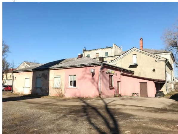
Vērtējamā Objekta ārskats, priekšplānā remonta darbnīca un šķūnis
