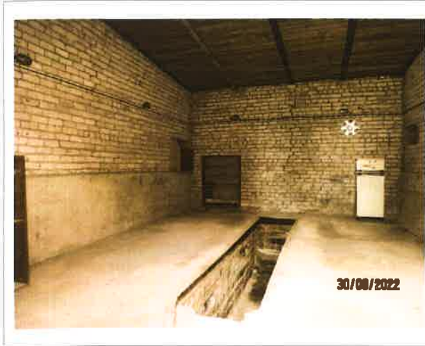
Garāžas iekštelpas, ēka lit. 002.
