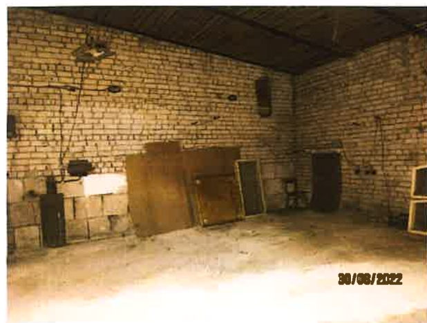
Garāžas iekštelpas, ēka lit. 002.
