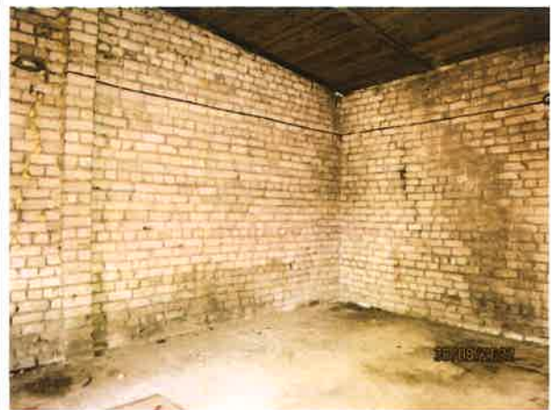
Garāžas iekštelpas, ēka lit. 002.
