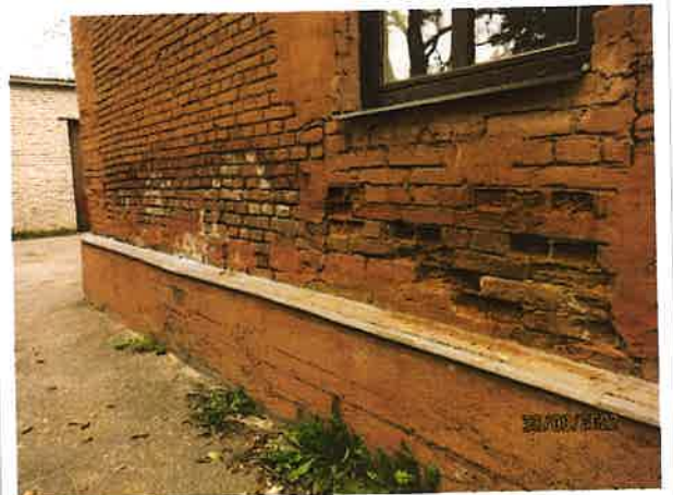
Ēkas pamat konstrukcijas.
