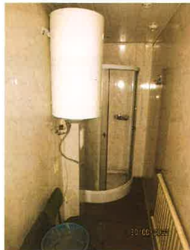
Sanitārtehniskā telpa pagraba stāvā. Telpa nr. 24.
