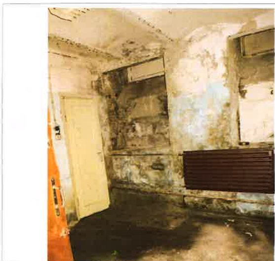
Palīgtelpa, telpa nr. 25.
