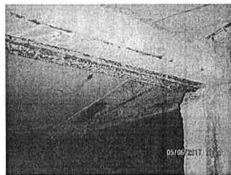
Fotofiksācija Nr. 6 Pagrabstāvā dzelzsbetona pārseguma sijām korodējusi armatūra un bojāta aizsargkārtā
