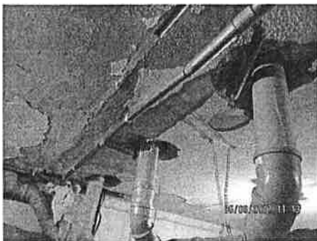
Fotofiksācija Nr. 9 Neblīvi inženierkomunikāciju šķērsojumi
