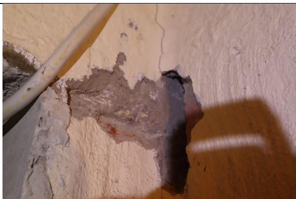
4.21.att. Ailas balsta vieta atsegums
