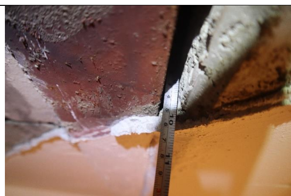
4.40.att. Pārseguma biezums (240 mm)
