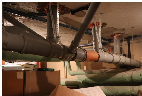
4.32.att. Inženierkomunikāciju šķērsojums pagrabstāva pārsegumā
