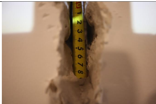
4.8.att. Tērauda elementa augstums (180 mm)
