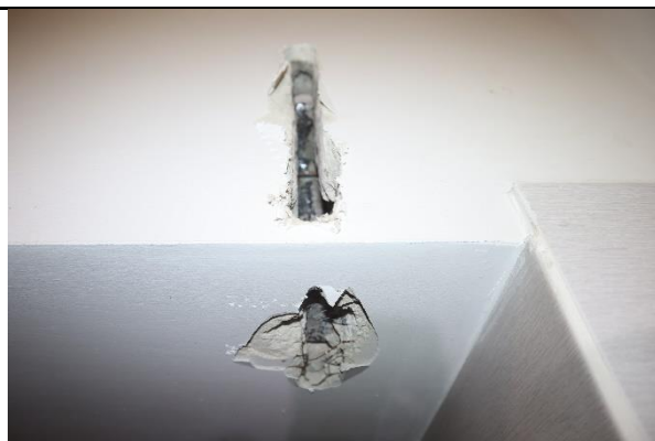
4.4.att. Tērauda elementa atkalšana
