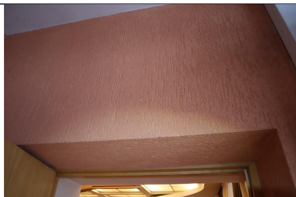
4.11.att. Patvaļīgi izbūvēta aila starp telpu Nr.7 un Nr.8
