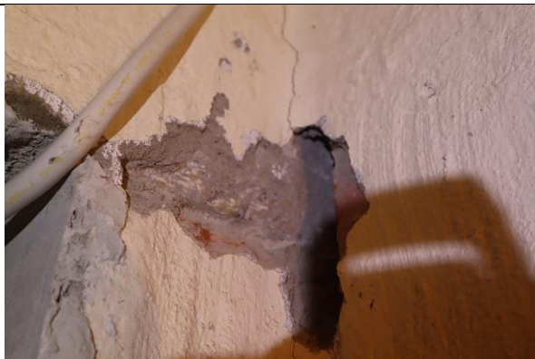
4.21.att. Ailas balsta vieta atsegums
