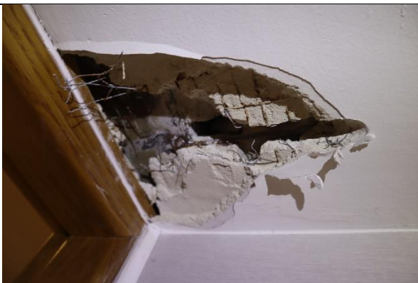
4.5.att. Tērauda elementa atkalšana
