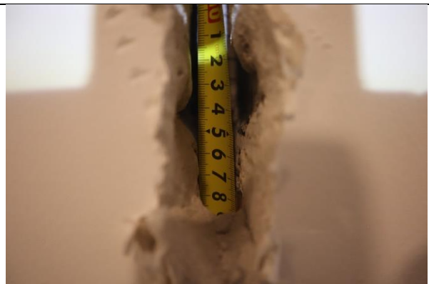
4.8.att. Tērauda elementa augstums (180 mm)
