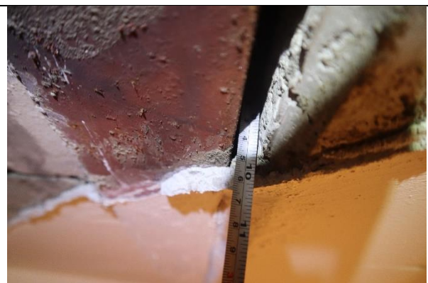
4.40.att. Pārseguma biezums (240 mm)
