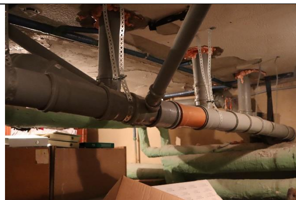
4.32.att. Inženierkomunikāciju šķērsojums pagrabskā pārsēgumā
