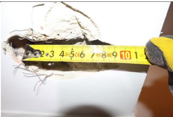
4.7.att. Tērauda elementa platums (70 mm)
