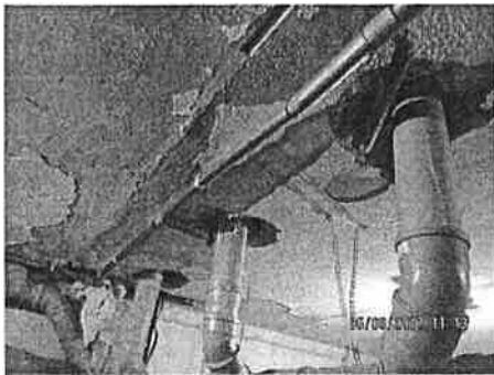
Fotofiksācija Nr. 9 Neblīvi inženierkomunikāciju šķērsojumi
