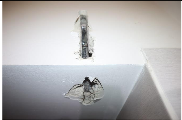
4.4.att. Tērauda elementa atkalšana
