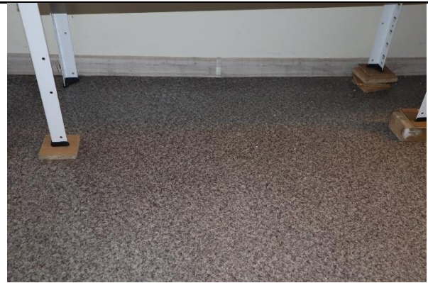
4.44.att. Paliktņi zem plauktu konstrukciju balstiem deformāciju izlīdzināšanai
