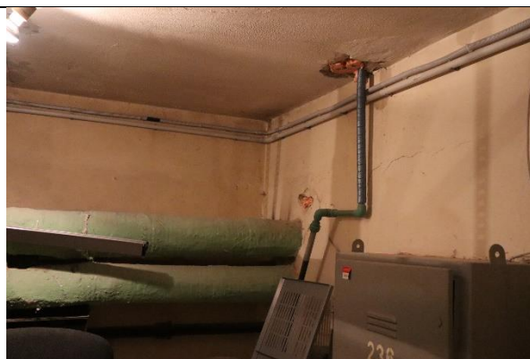
4.31.att. Inženierkomunikāciju šķērsojums pagrabskā pārsēgumā
