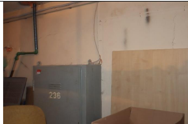
4.34.att. Plaisu atvērumi ķieģeļu mūra nesošajās sienās
