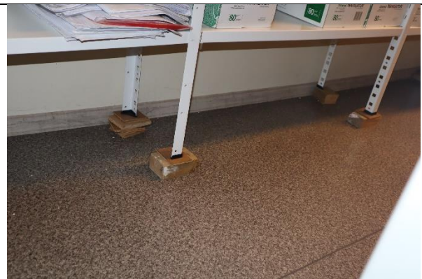
4.46.att. Paliktņi zem plauktu konstrukciju balstiem deformāciju izlīdzināšanai
