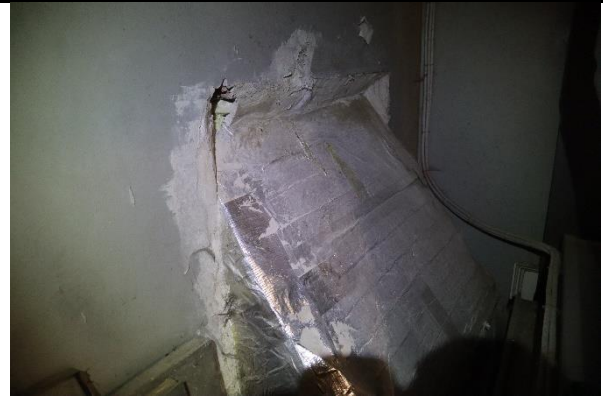
4.27.att. Ventilācijas izvada atvērums telpā Nr.24
