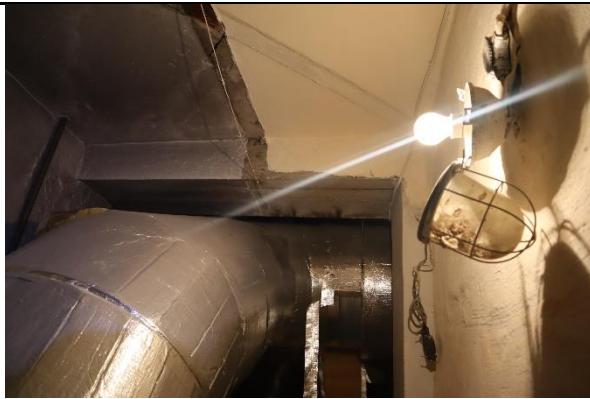
4.37.att. Dzelzbetona ailu pārsedzes starp telpām Nr.22 un Nr.23
