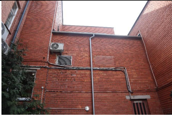
4.26.att. Atvērums un aizmūrējums uz otrā stāva telpu Nr.24
