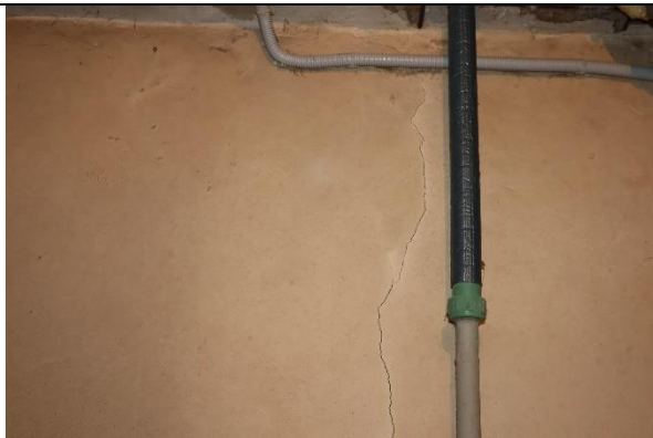
4.33.att. Plaisu atvērumi ķieģeļu mūra nesošajās sienās
