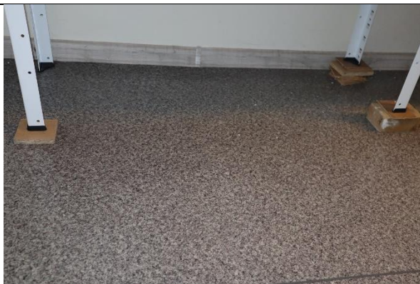
4.45.att. Paliktņi zem plauktu konstrukciju balstiem deformāciju izlīdzināšanai
