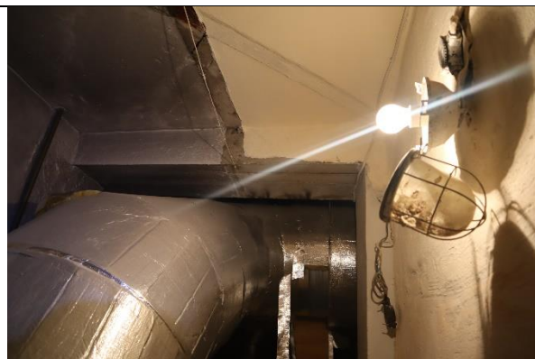
4.17.att. Ailu pārsedze starp telpu Nr.22 un Nr.23
