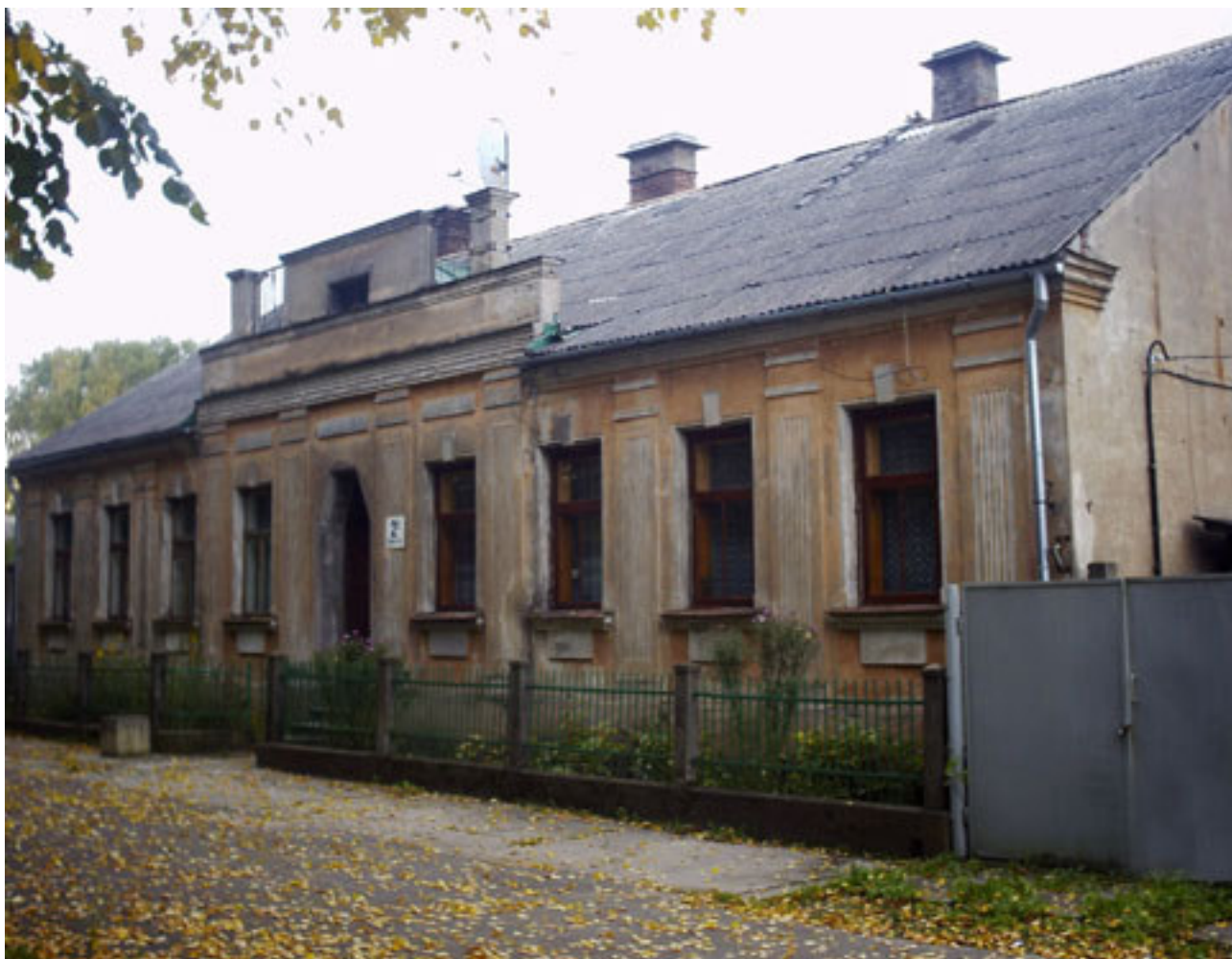
Nr.4826 Dzīvojamā ēka Tīrgus ielā 2b
