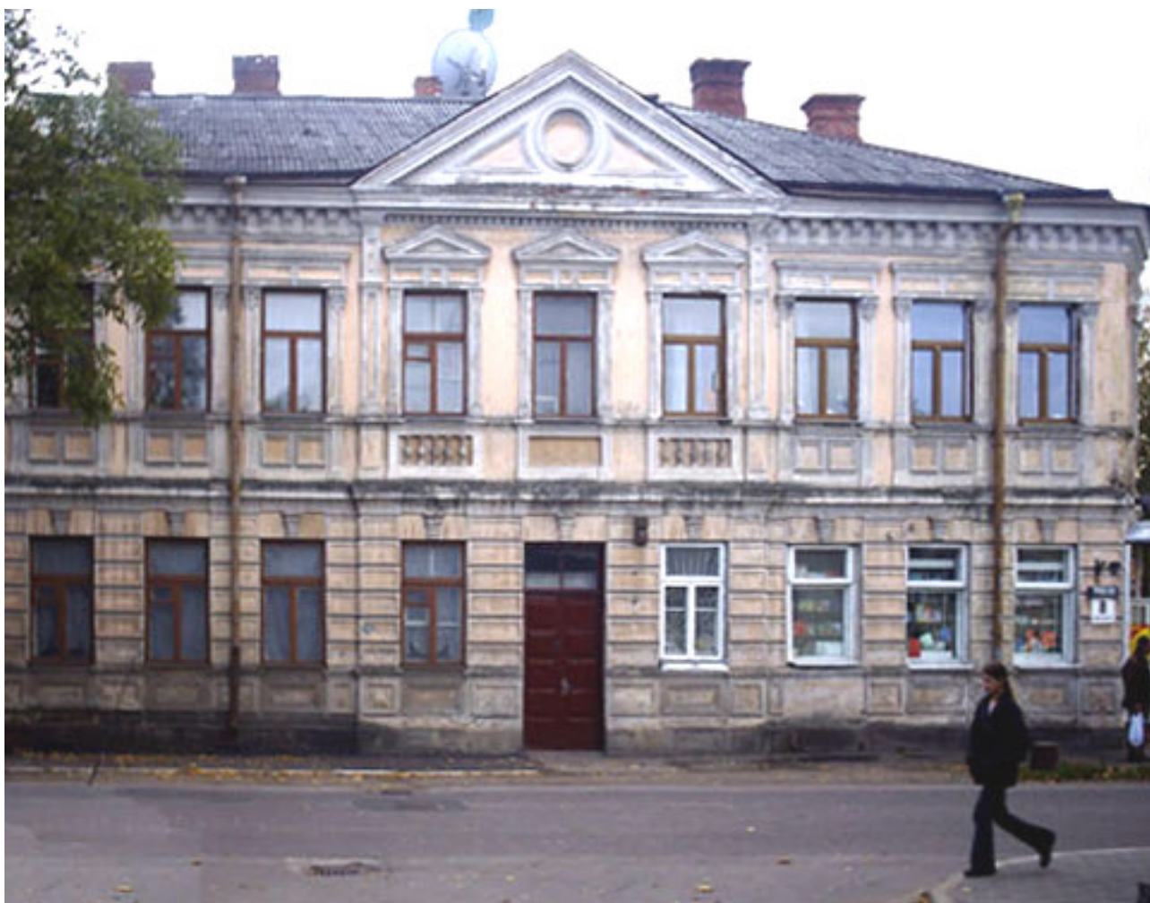
Nr.4791 Dzīvojamā ēka Nometņu ielā 8
