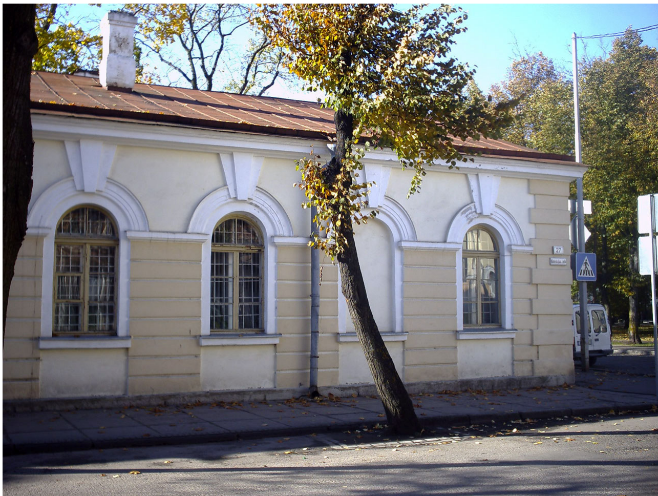
Nr.4769 Administratīvā ēka Ģimnāzijas ielā 27
