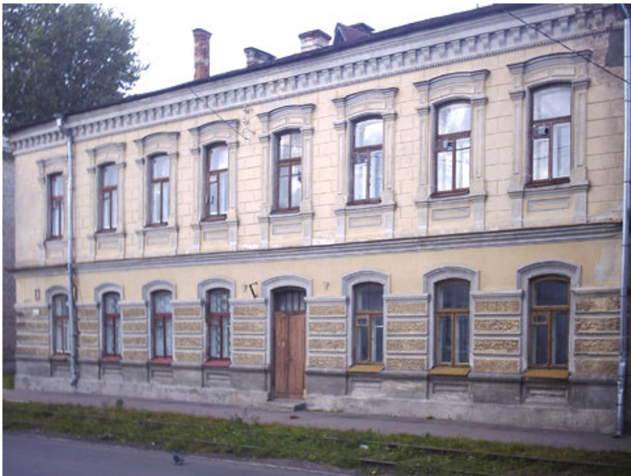
Nr.4761 Dzīvojamā ēka Februāra ielā 33
