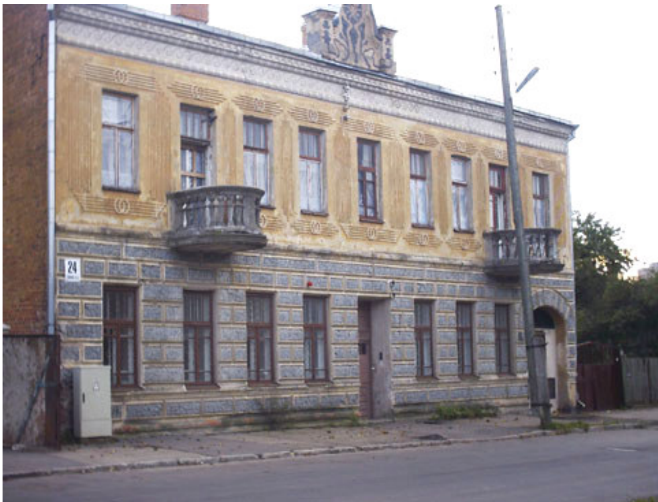
Nr.4760 Dzīvojamā ēka Februāra ielā 24
