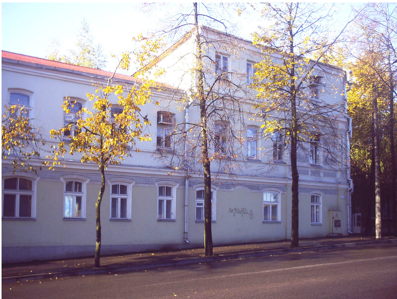
Nr.4821 Dzīvojamā ēka Stacijas ielā 69
