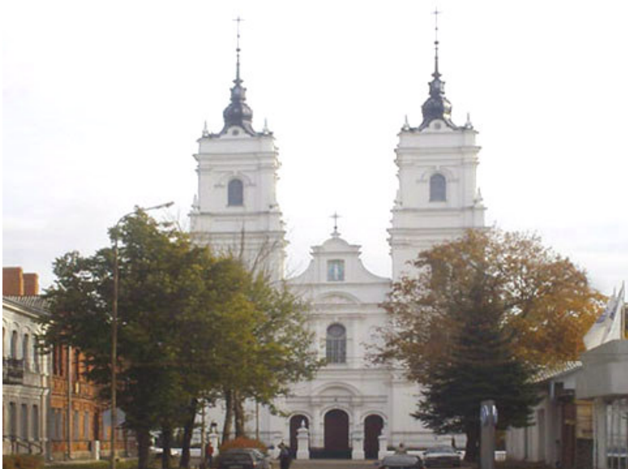
Nr.4794 Jaunavas Marijas katoļu baznīca A.Pumpura ielā 11a
