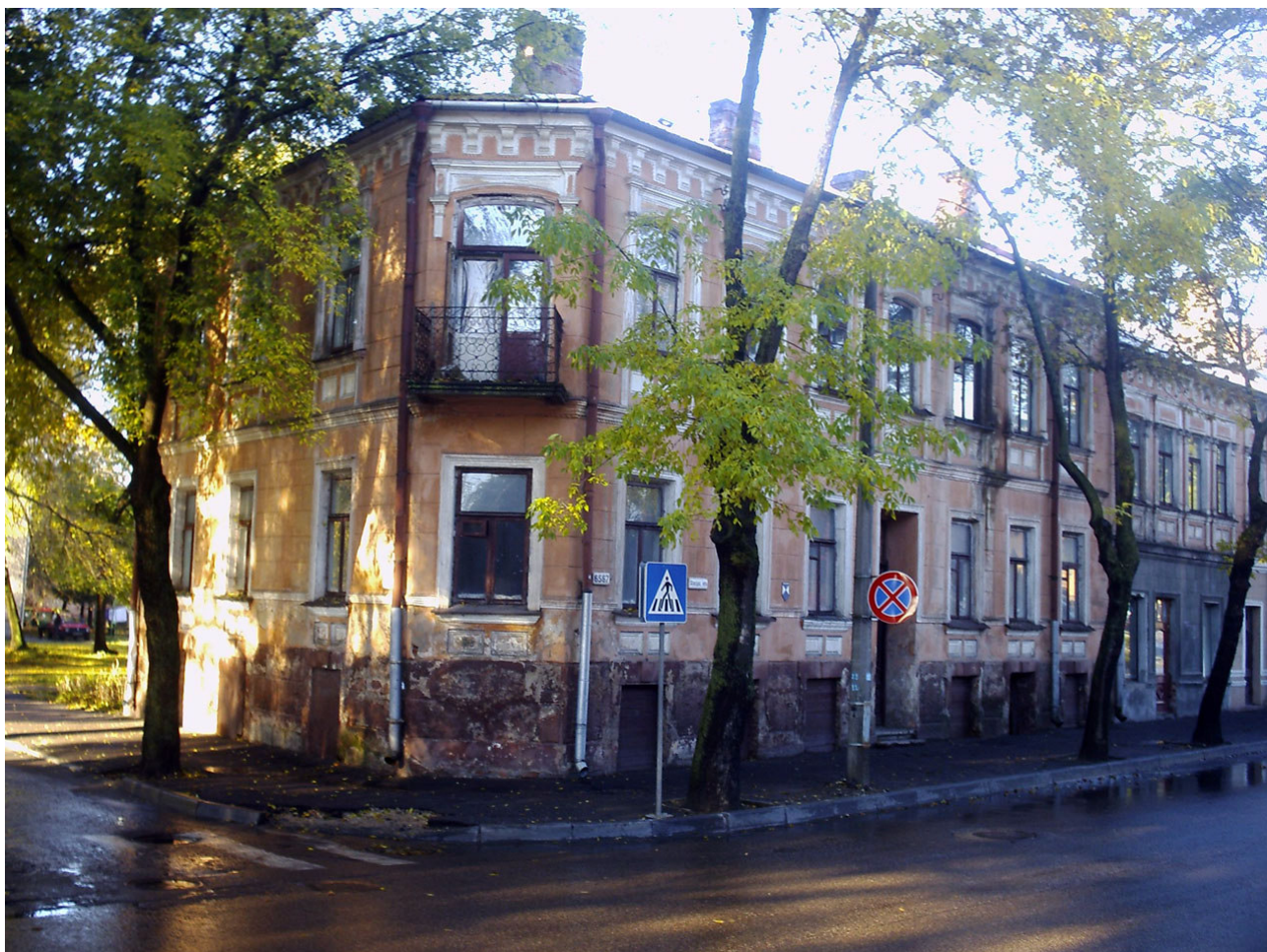
Nr.4820 Dzīvojamā ēka Stacijas ielā 65/67
