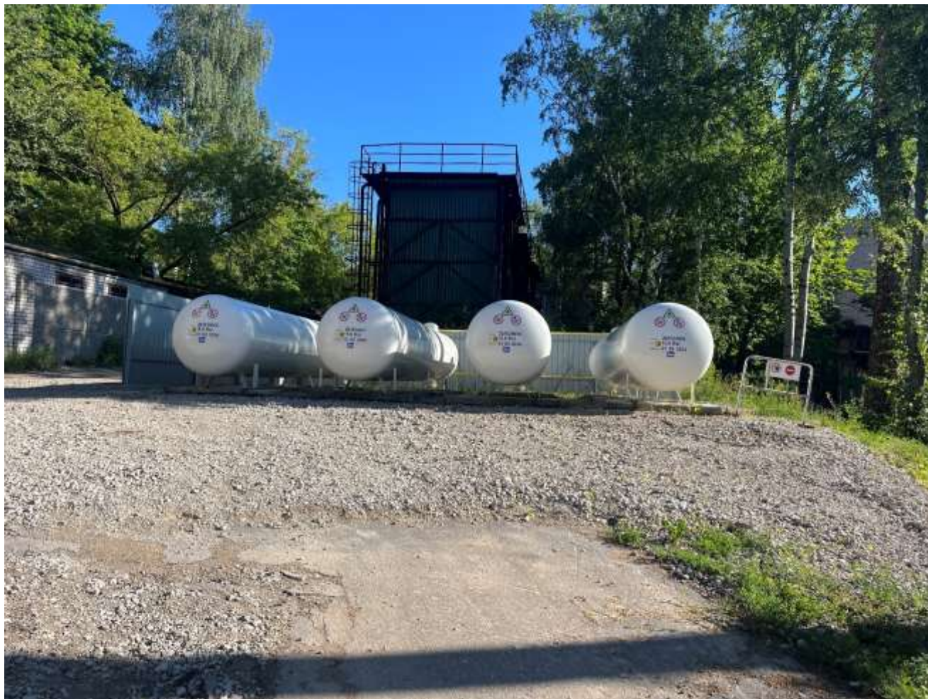
4.3.att. AS “Daugavpils Lokomotīvu Remonta rūpnīca” SNG tvertnes objektā Marijas ielā 1, Daugavpilī
